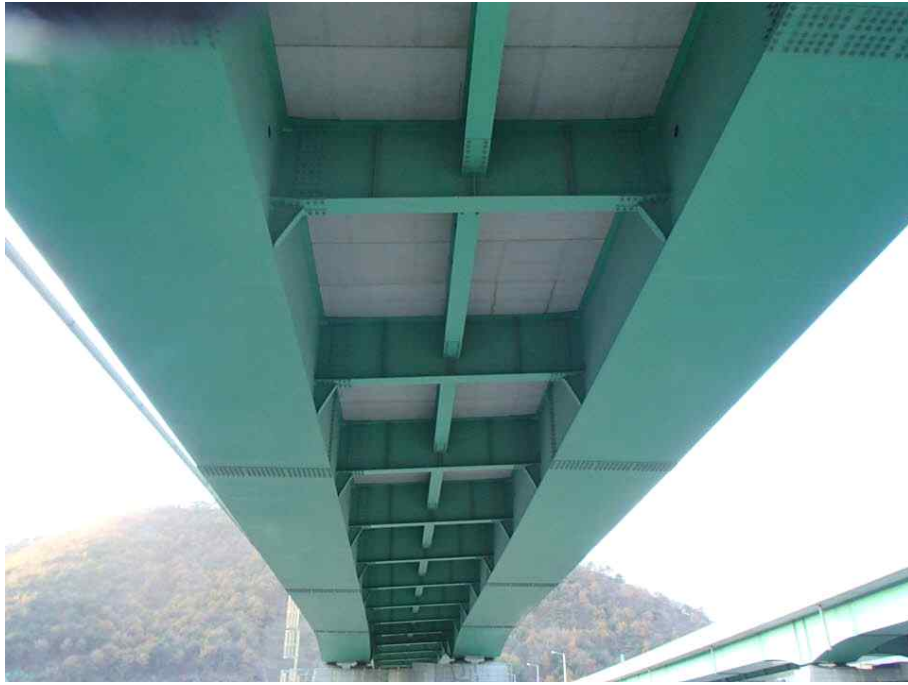
Steel Box Girder 외부 전경
