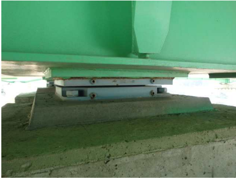
받침장치 전경 (고정단)
